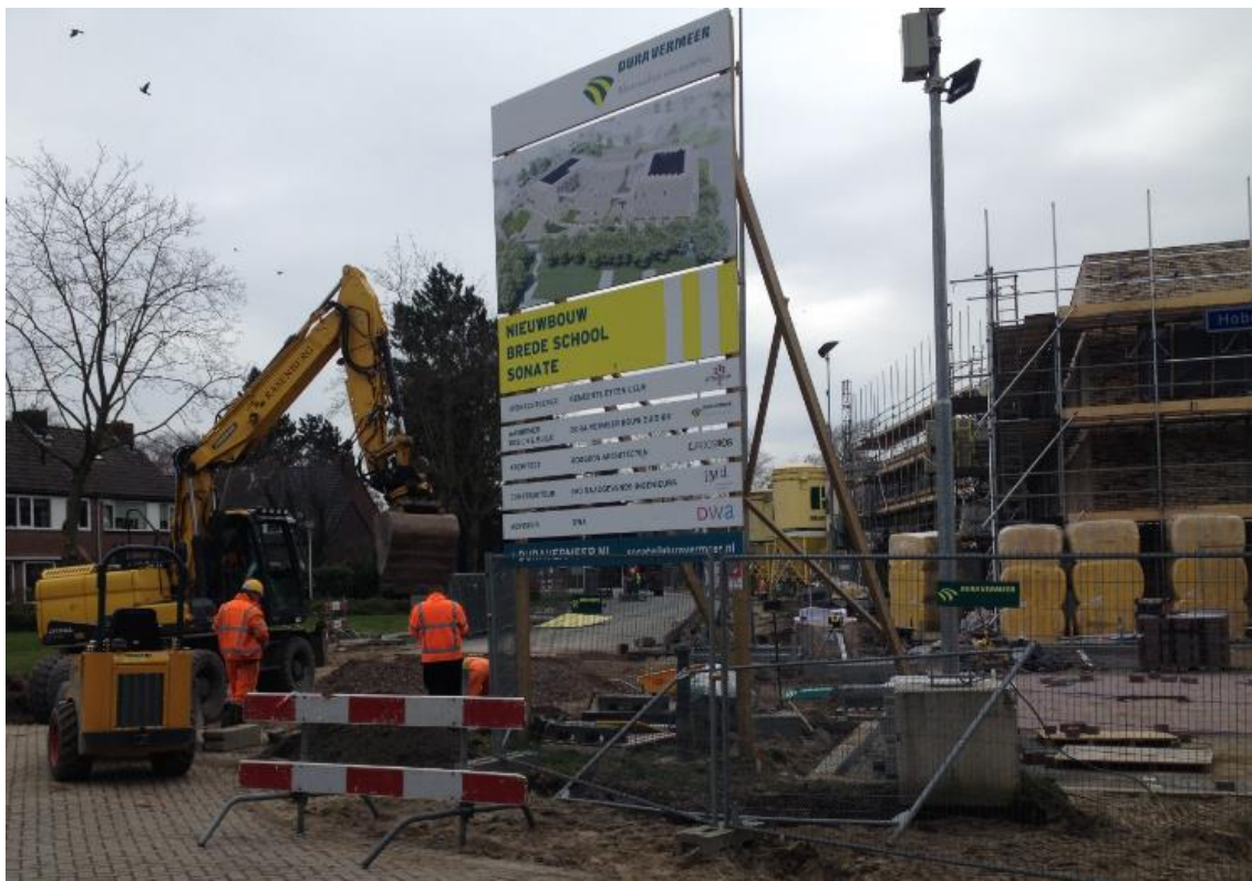
Nu is de weg afgesloten om te zorgen dat de nieuwe parkeerplaats doorloopt naar de straat.
