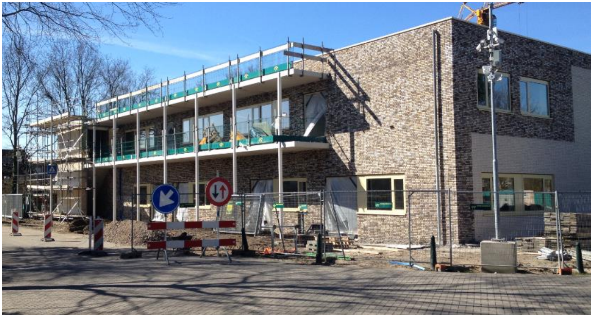
De kozijnen zijn al geplaatst.
