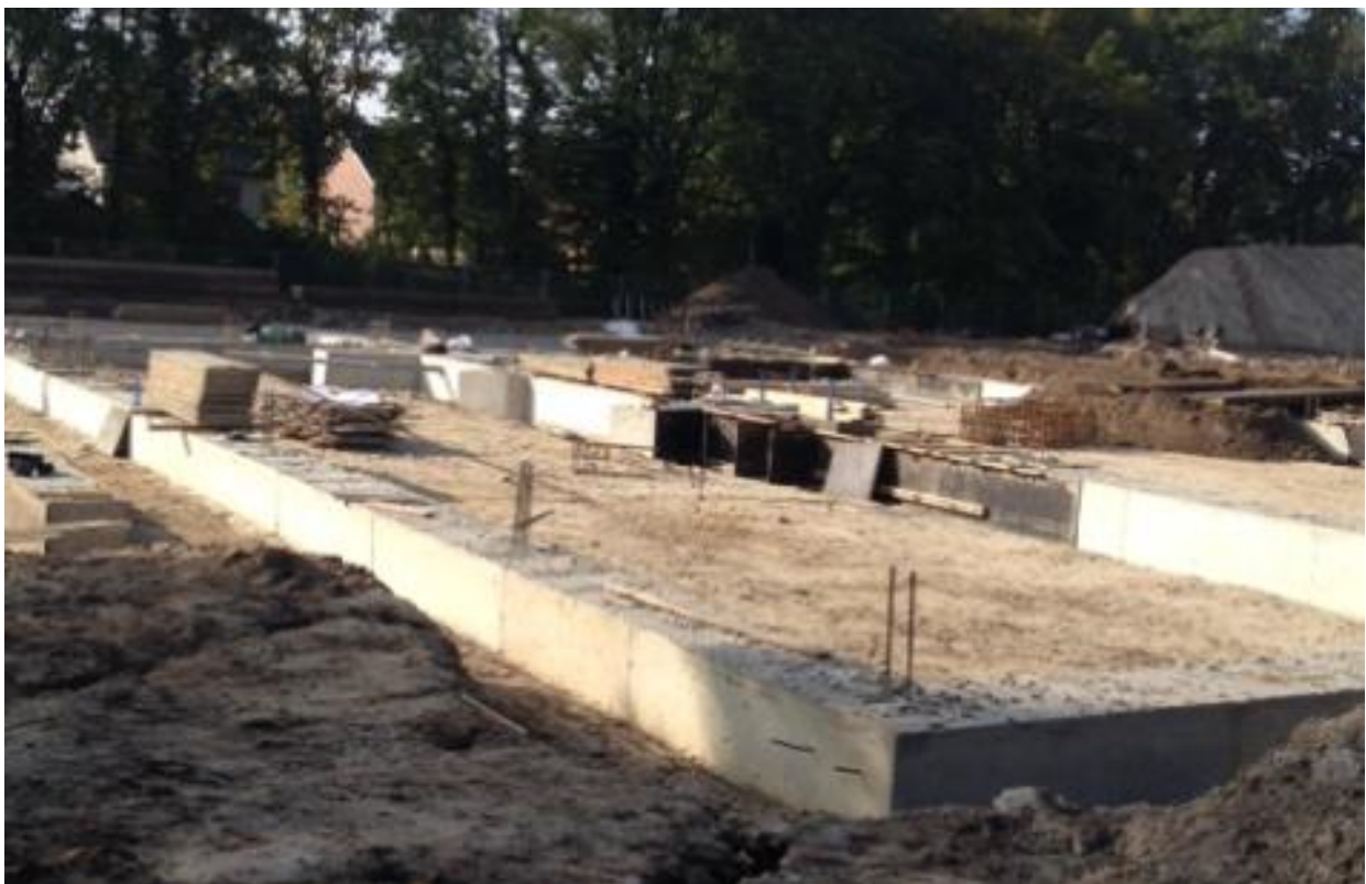
Hier zie je het fundament. Dat moet heel stevig zijn.
