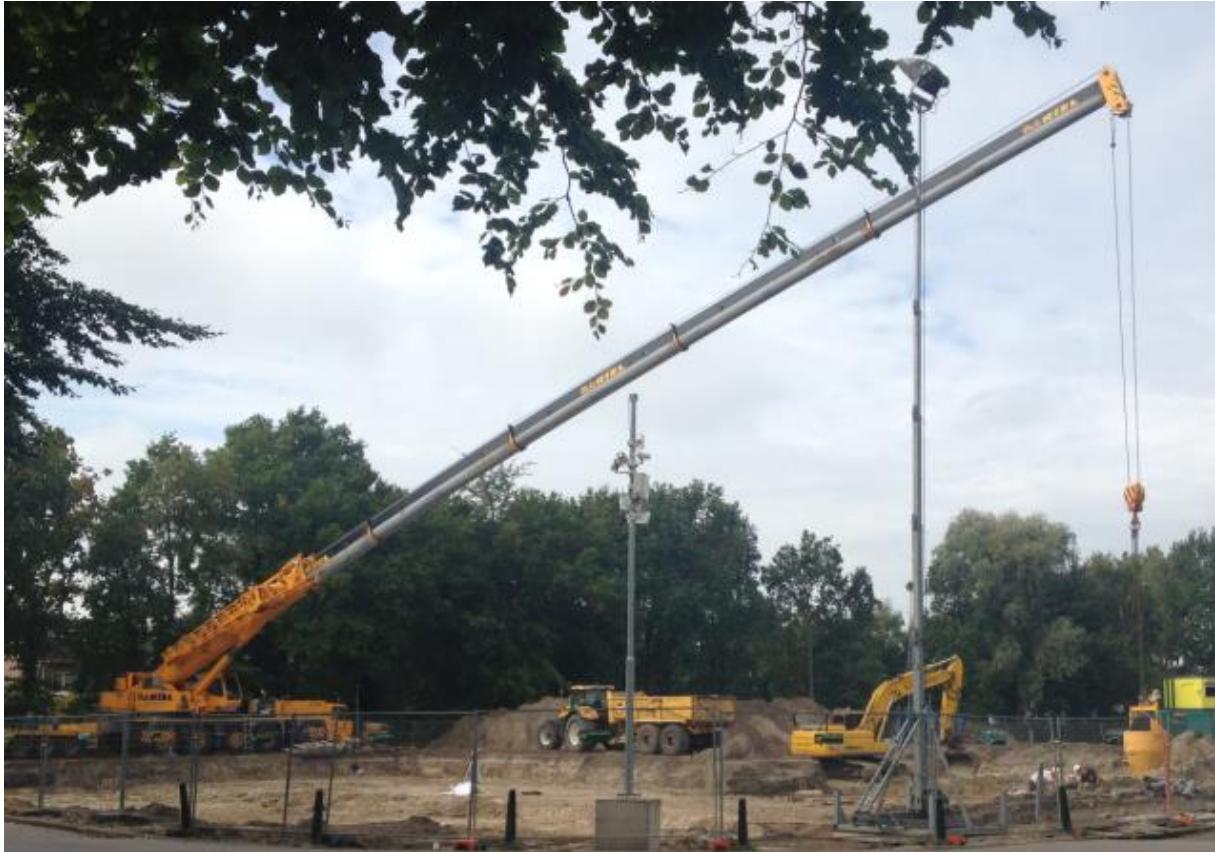
De hijskraan tilt een bak met beton. Daarmee maken ze balken. Dat heet : fundament.
