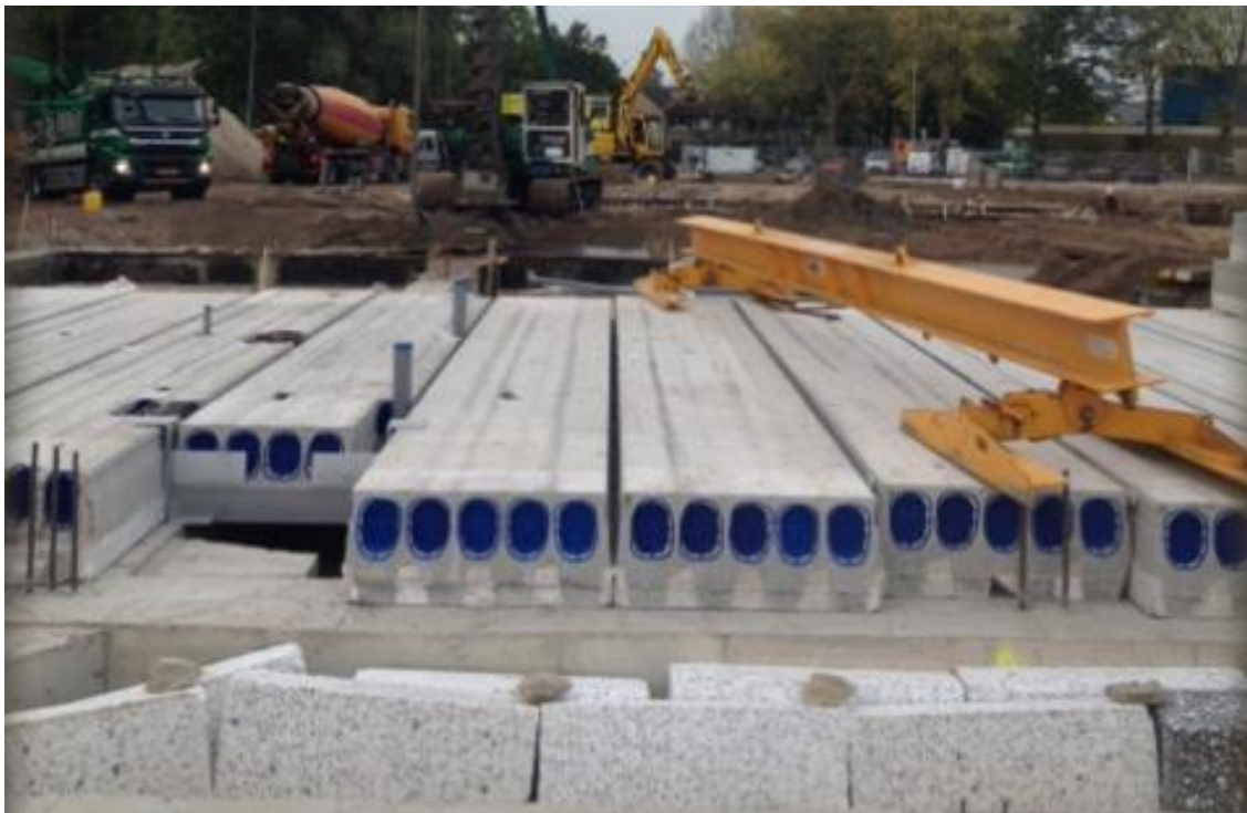
Op de fundamenteën legt de hijskraan dikke vloerbalken.
