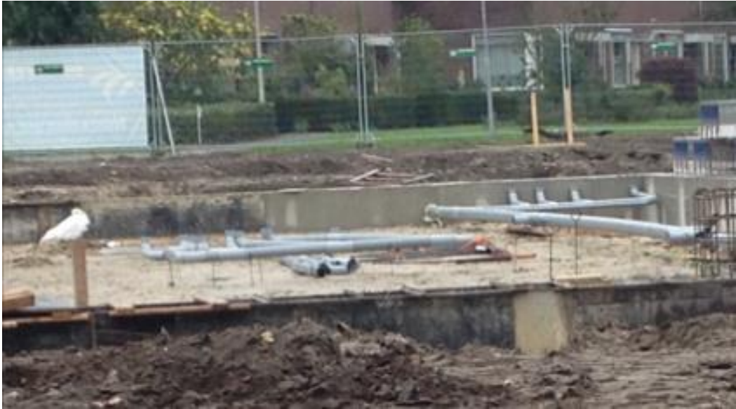
Tussen de fundamenteën komen de buizen voor het vuile water. Dat is de riolering.
