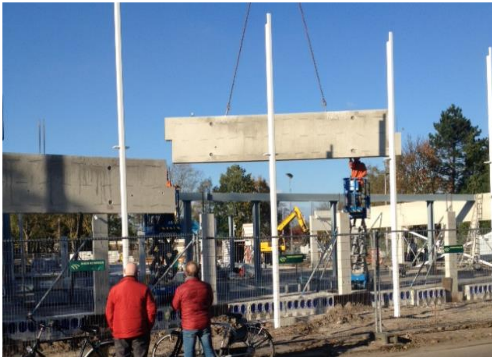
Al gauw kwamen er meer palen. Met betonnen randen werd het stevig gemaakt.
