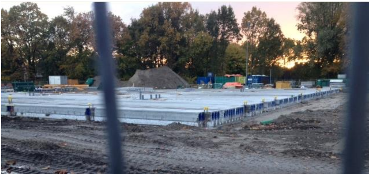
Dit is de kant van de Klankhof. Ze zijn nog met de vloer bezig.
