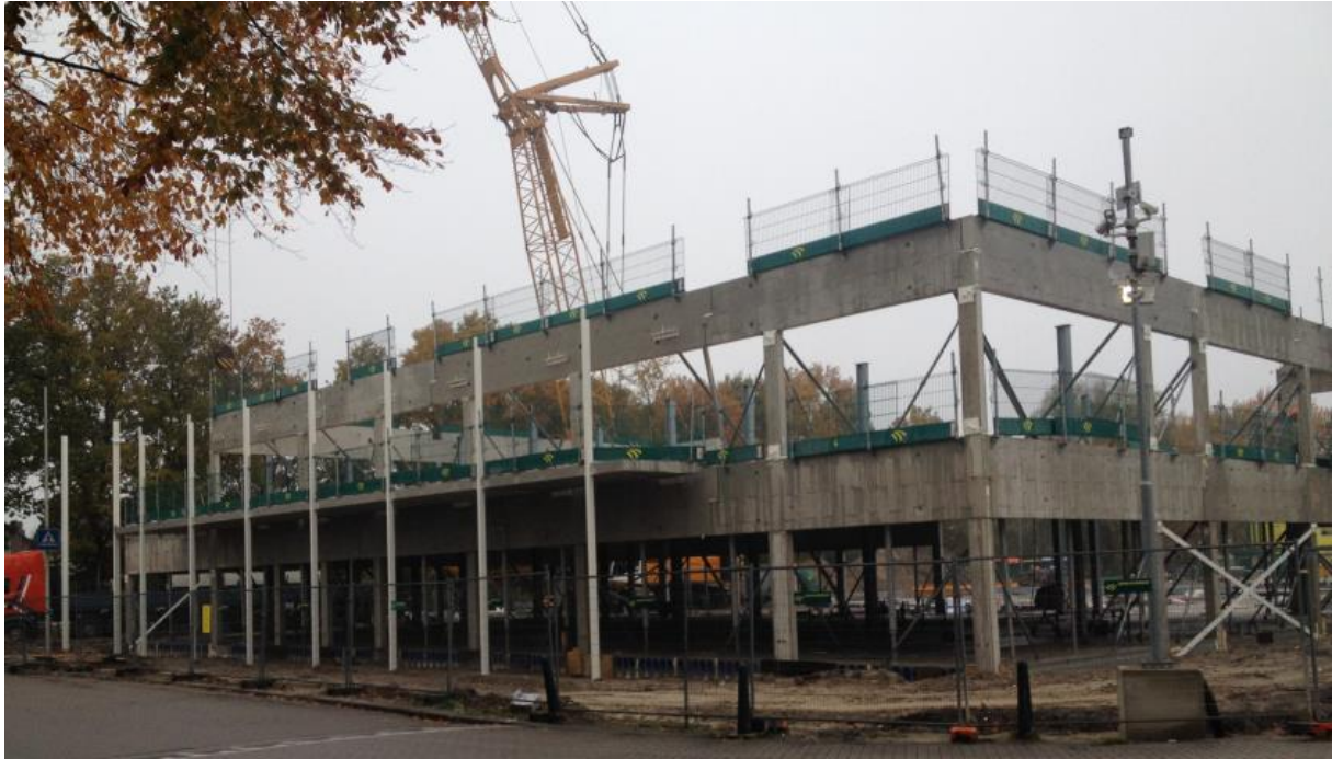
Hier zijn ze al aan de 2 de verdieping begonnen.
