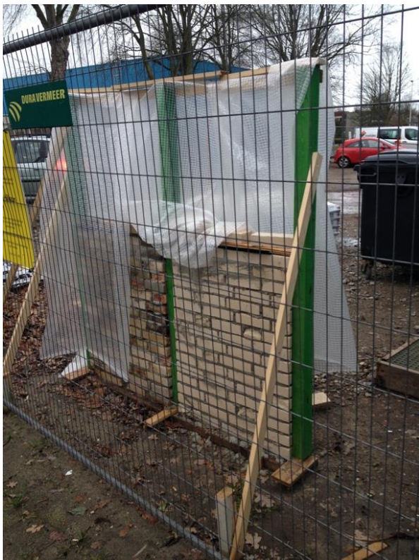
Dit is het proefmuurtje. zo willen de metselaars het maken
