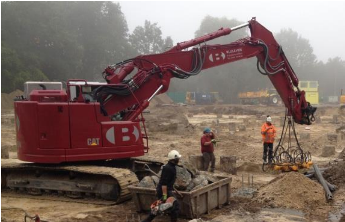
Dat gele ding is een hele sterke knijper. Hij knijpt de bovenkant van de paal eraf.
