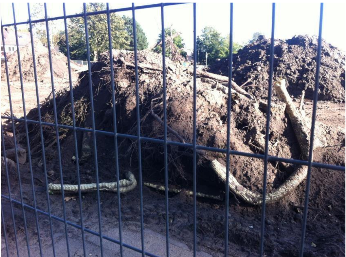
De bouwers moesten al de rommel uit de grond opruimen die was achter gebleven
