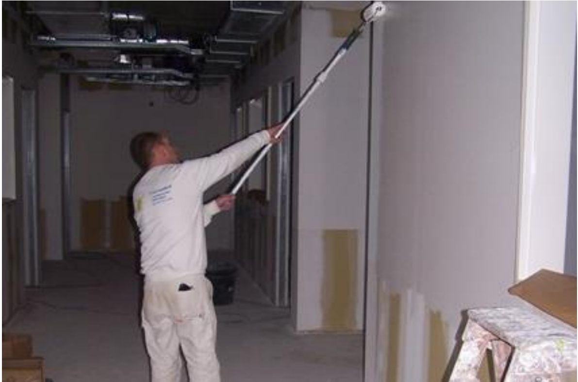
Hier staat een van de bouwers de muur te verven.
